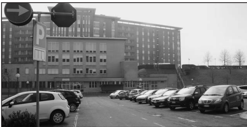
Il parcheggio interno dell'ospedale.
